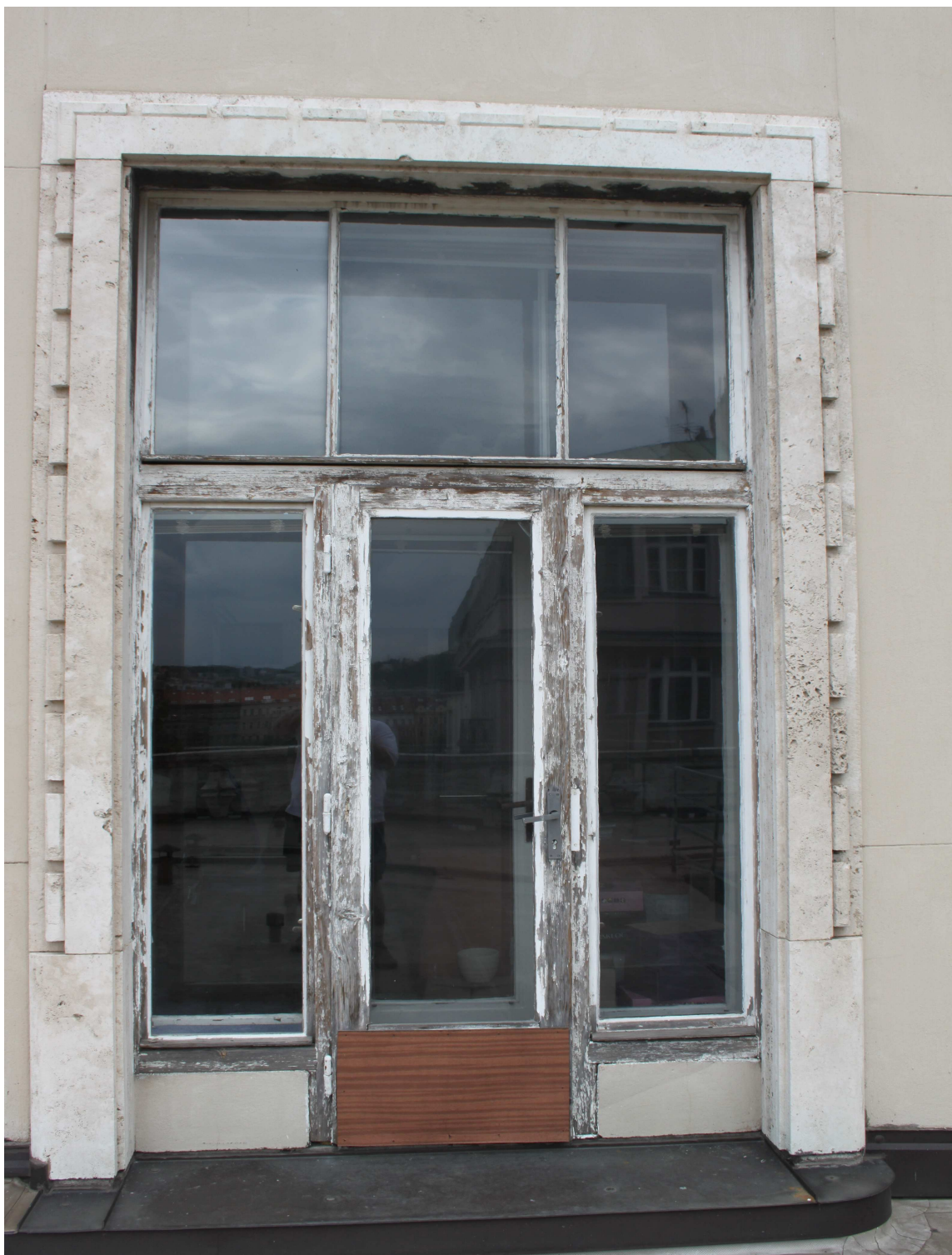
Špaletové dveře s oknem a pevnou výplní – návrh repasování
