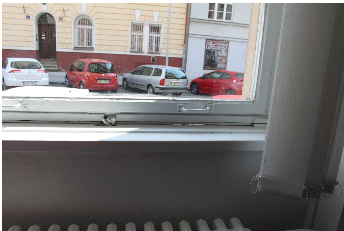
Stav posuvných oken – mezera pod zavřeným oknem
