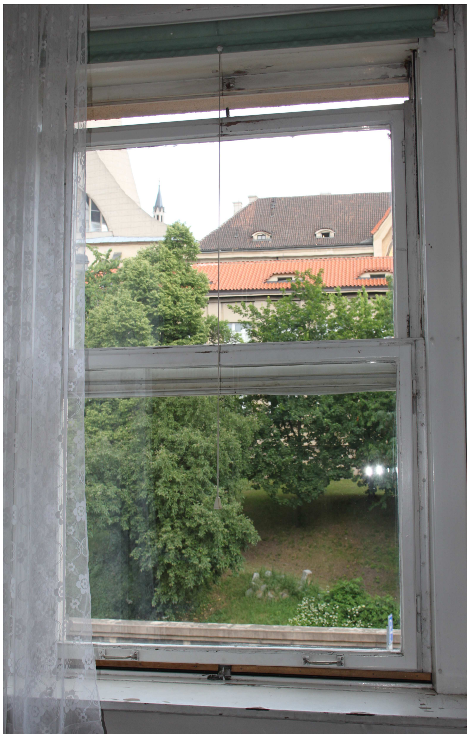
Stav posuvných oken – dodatečné zališťovanie okolo okna snaha o dotěsnění, křídlo nelze otevírat
