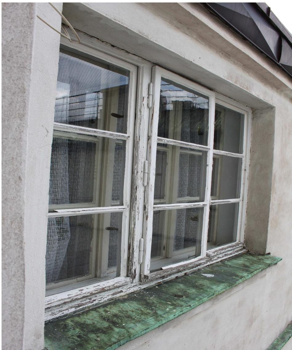
Stav špaletových oken – návrh repasování
